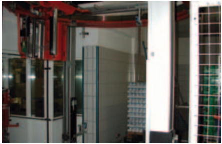
Contrôle de porte-à-faux dans la mécanutention
