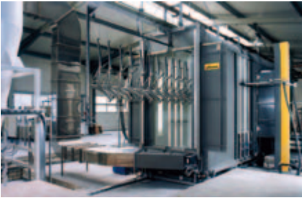
Installation de revêtement par poudre
